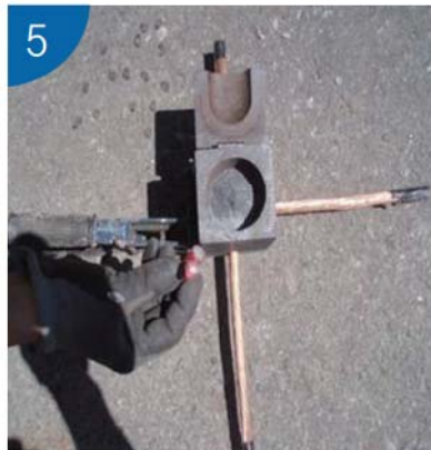
5 MOLD와 도체가 정확히 연결되었는지 확인한다.
