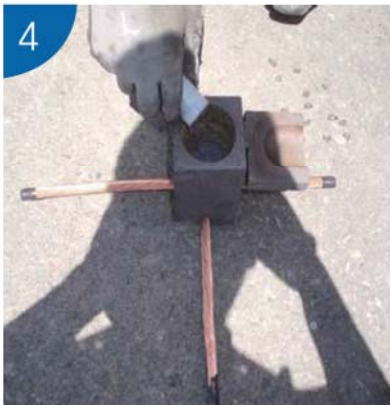
4 MOLD안에 WELD METAL을 부어 넣는다.
